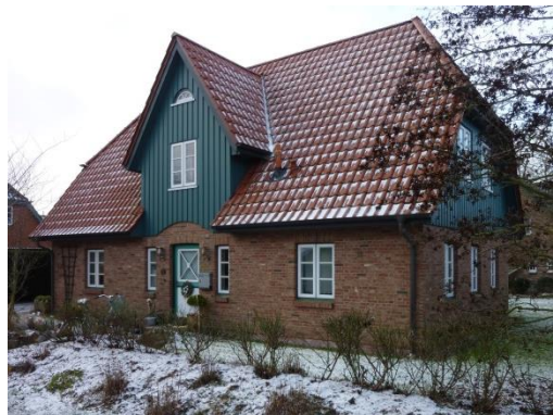
Abbildung 60: Augenscheinlich in gutem Zustand
