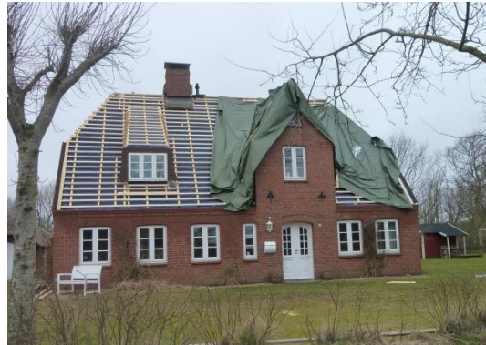
Abbildung 58: Gebäude in der Modernisierung
